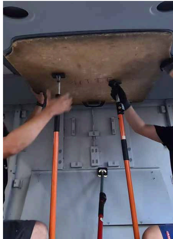
Sichern mit Stützen
