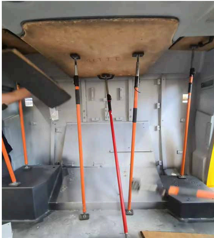
Entfernen der Stützen
